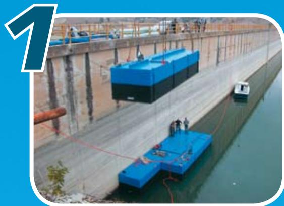
**Assemblaggio rapido dello scafo tramite spine superficiali.**
